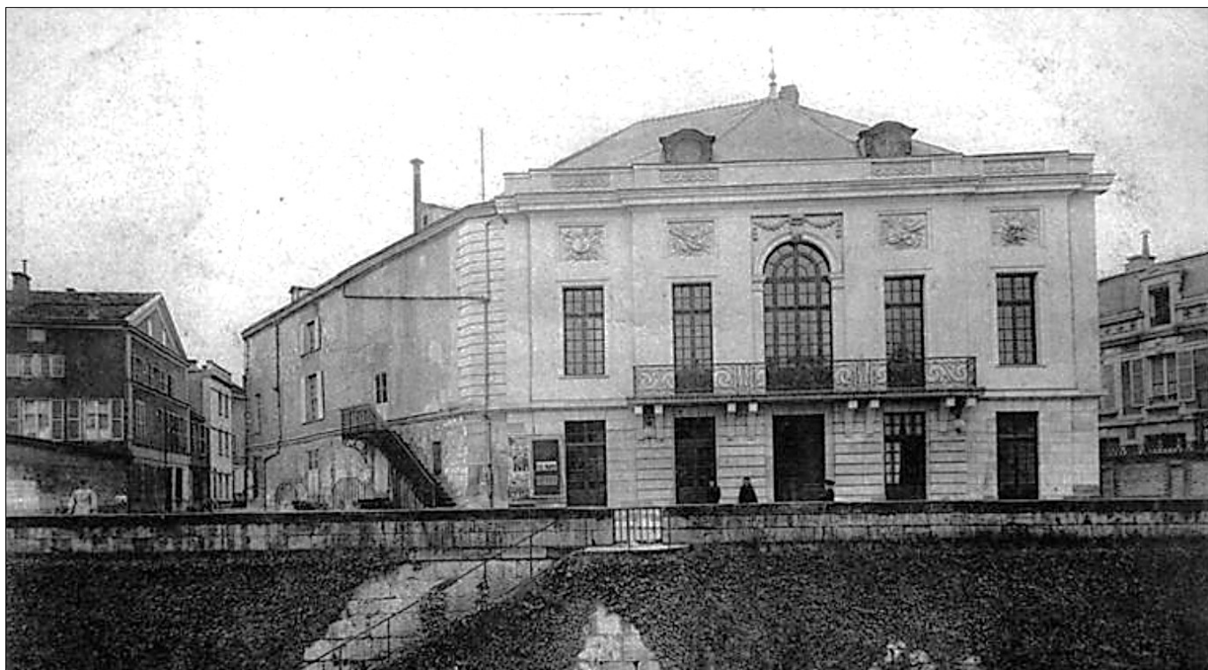
Façade du théâtre de Châlons.
